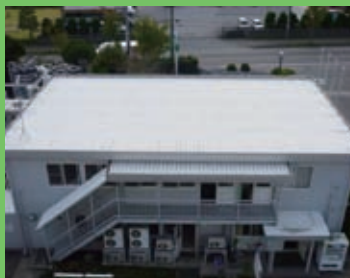
▲事務所棟屋根に遮熱塗装を施工しました(茨城工場)。
