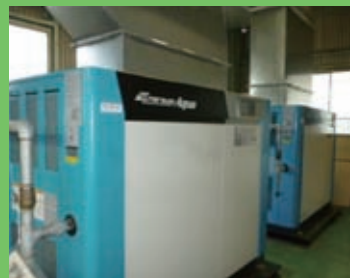
▲空気圧縮機を小型(能力の適正化)に更新しました(ハリマエムアイデイ)。
