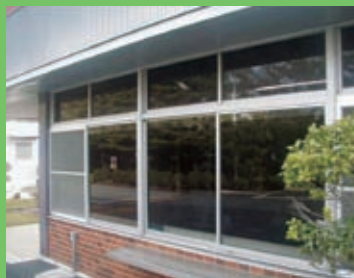
▲事務所の窓に遮光フィルムを貼り、冷房効率向上を図りました(東京工場)。
